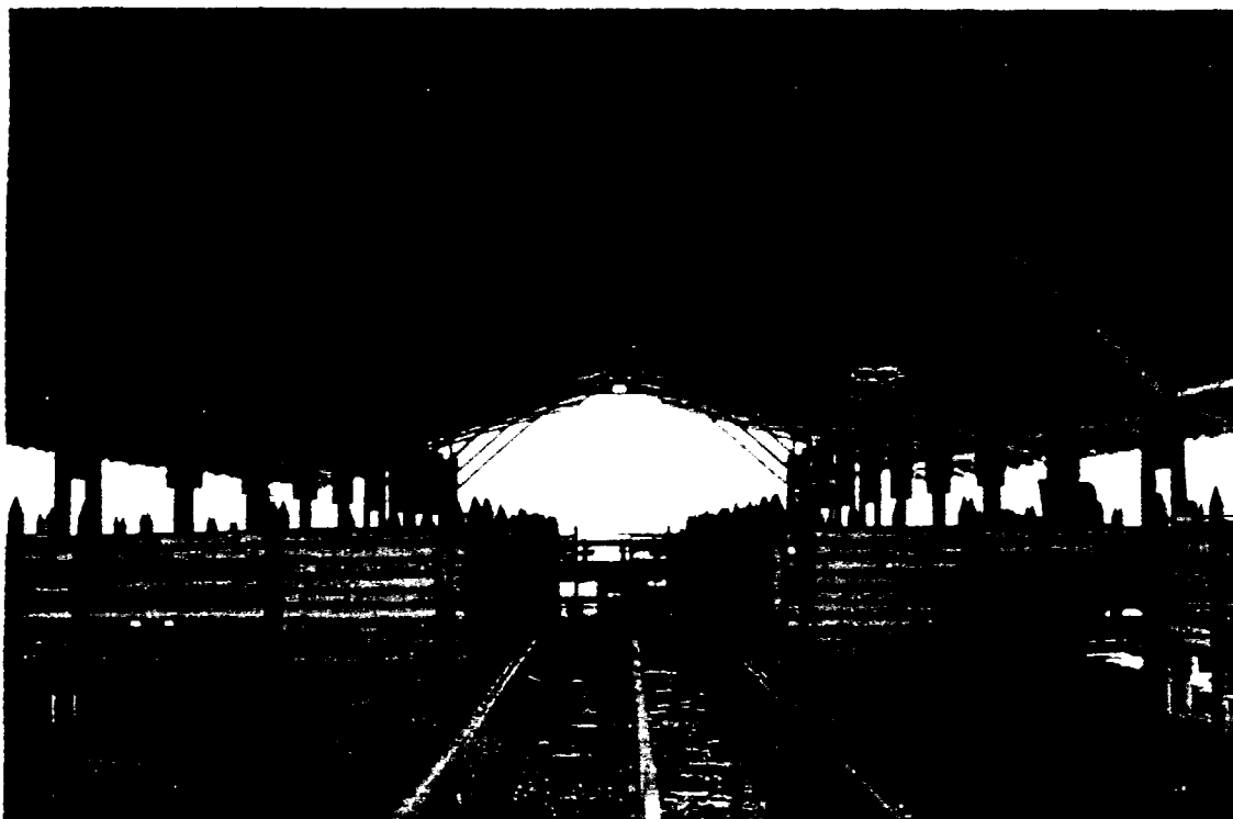
Establo con estructura de guadua para soportar los techos. Obra de Simón Vélez, Caldas, Colombia.
